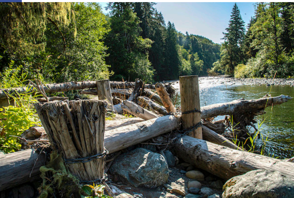
Los apilamientos de troncos artificiales como este instalado en el río South Fork Nooksack pueden reducir el riesgo de inundaciones al reducir la velocidad del flujo del río. Fotografía: Lance Cheung/USDA NRCS
