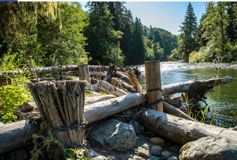
Các nút chặn gỗ được thiết kế như thế này được lắp đặt ở Nhánh Phía Nam của Sông Nooksack có thể giảm nguy cơ lũ lụt bằng cách làm chậm dòng chảy của sông. Ảnh: Lance Cheung/ Cục Bảo Tồn Tài Nguyên Thiên Nhiên (Natural Resources Conservation Service, NRCS) thuộc Bộ Nông Nghiệp Hoa Kỳ (United States Department of Agriculture, USDA)
